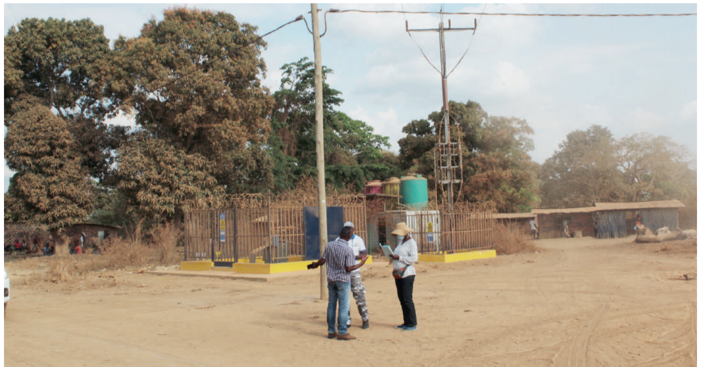
Electrification rurale dans le bassin agricole de Dihessé (Bouenza)
